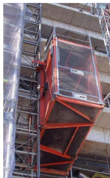
Ascensor de Obra
